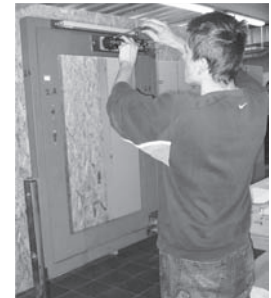
Abb. 10: Montage der Schließanlage im Rahmen der üA
